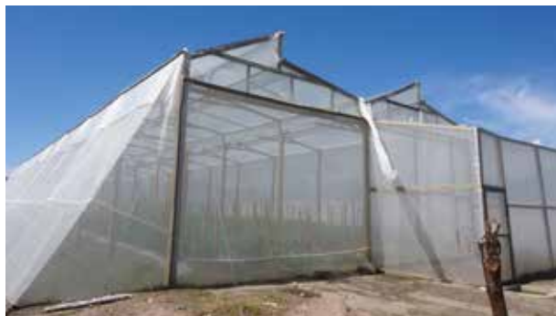
Sistema de producción bajo estructura protegida, Casa Malla
